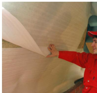
9. Полотнища пароизоляции устанавливают с перехлестом 10 см и склеивают специальной лентой типа скотч. Эффективным является использование фольгированных пароизоляционных пленок, которые не только являются барьером для диффундирующей из внутренних помещений влаги, но и материалом, отражающим поток лучистого тепла назад в помещение.
