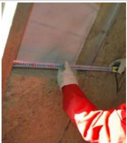
**5. Монтаж необходимо вести снизу вверх, плотно прижимая теплоизоляционные плиты друг к другу. Такой порядок монтажа поможет избежать щелей между плитами, которые приводят к промерзанию, и как следствие, образованию наледей на поверхности кровли.**
