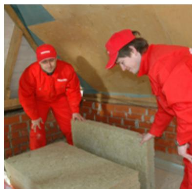
**3. Благодаря высокой плотности материала ( $37 \text{ кг}/\text{м}^3$ ) он легко разрезается ножом. Для подрезки плит необходимо использовать нож с длиной лезвия большей, чем толщина материала. Ломать или рвать плиты не допускается.**
