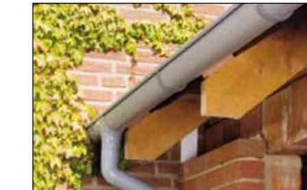
Отдельные детали системы водосточных труб просто вставляются друг в друга. В связи с достаточной глубиной вставки фасонных деталей уплотнения не требуются.
