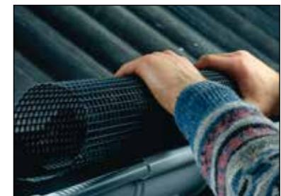
Сетчатая труба Poly-Net Laubstop укладывается в водосточный желоб и фиксируется там за счет собственной эластичности. Легко обрабатывается, так как Marley Poly-Net Laubstop поставляется длиной в 2,00 м.
