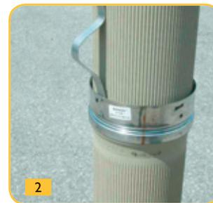
Для придания конструкции статической устойчивости на каждом соединении керамических труб устанавливается манжета с распорными элементами. На манжеты в соответствии с инструкцией навешиваются распорные элементы и изгибаются так, чтобы они плотно прилегали к стенкам имеющейся шахты (Рисунки 1 и 2).
