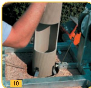
При помощи спусковой лебёдки (W4) опустить профилированную трубу с вырезом (2a/b) в шахту до раструба (Рисунок 10).
