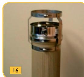
1. Статическую манжету кольцом большого сечения одеть сверху на раструб профилированной трубы Keranova и зафиксировать
