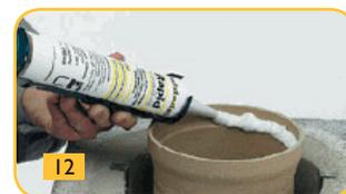
Нанести специальную массу Rapid (8a), или массу FM (8c) для герметизации швов, или массу Rotempro (8b) в раструб профилированной трубы (Рисунок 12).
