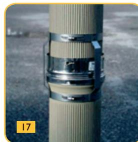
3. Нанести массу для заделки швов, Rapid (8a) или Rotempo (8b) 4. Вставить через верхнее кольцо статической манжеты следующий элемент трубы, установить его, выровнять шов, после чего закрепить верхнее кольцо статической манжеты. (Рисунок 17)
