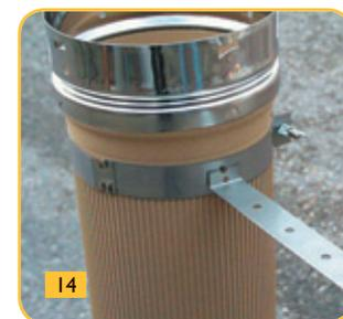
Таким же образом смонтировать требуемое количество профилированных труб (2a/b) до отметки верхней ревизионной дверцы или до устья дымовой трубы (Рисунок 13).
