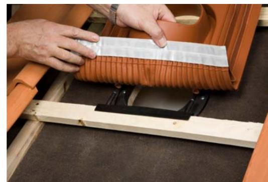
**RUS:** Снять черепички ниже отверстия. Вставить штыри упора в отверстия проходного элемента. Если обрешетка очень частая, то в некоторых случаях приходится подстругать рейки для размещения выступа на нижней части проходного элемента между рейками.
