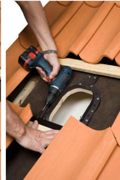
**RUS:** Планку упора закрепить к нижней рейке обрешетки двумя шурупами 80 мм строго симметрично относительно отверстия.
