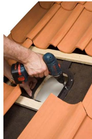
**RUS:** Прибить уплотнитель гидрозатвора гвоздями к сплошной обрешетке. При полимерной пленке и отсутствии сплошной обрешетки, завести уплотнитель под пленку, наколоть пленку на шипы и сильно прижать пленку к промазанному силиконом уплотнителю.
