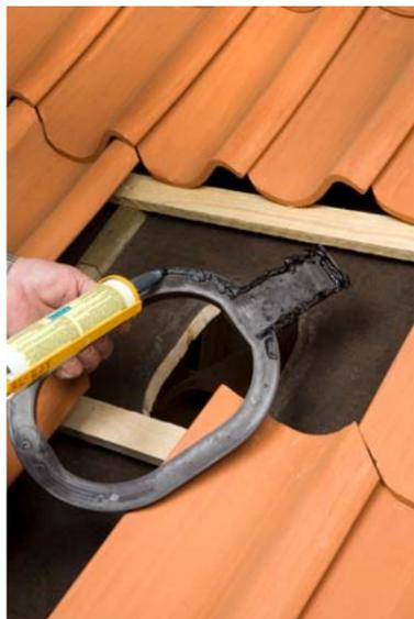
**RUS:** Если подкладочный материал- битумный, то промазать битумным клеем нижнюю поверхность уплотнителя гидрозатвора.
