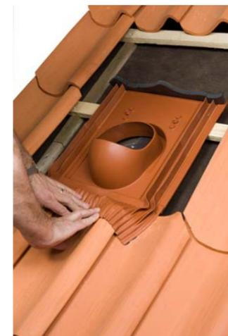
**RUS:** Убедиться, что под гофрированной гибкой частью проходного элемента черепица не имеет острых краев. Если профиль черепицы очень высокий или края острые, рекомендуется сточить край черепицы под гибкой частью. Результат будет выглядеть лучше. Снять защитную пленку и плотно прижать гофрированную часть по всей длине к черепице.
