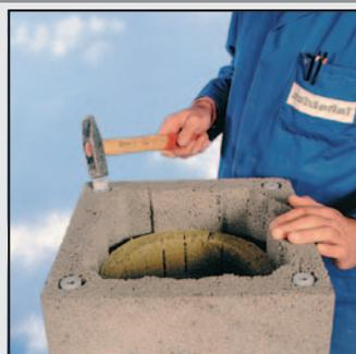
43 При монтаже готовой покровной плиты установите дюбели в отверстия верхней каменной оболочки.
