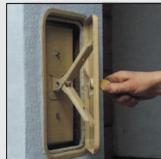
56 Удалить транспортный фиксатор с рычага дверцы и прижать внутреннюю часть дверцы путем закрывания наружной дверцы.
