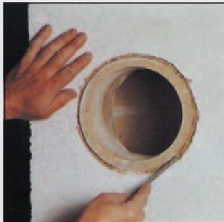
34 При проведении отделочных работ ещё до затвердевания штукатурки сделайте разделительную канавку между керамическим элементом дымовой трубы и штукатуркой.
