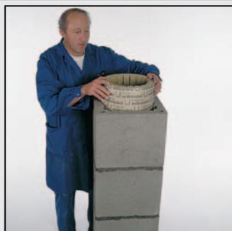
26 Изоляционные плиты согните, вставьте внутрь каменной оболочки и вместе опустите вниз. Изоляционные панели устанавливайте всегда до монтажа внутренних керамических элементов.
