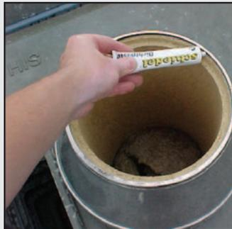
50 Шов между внутренней керамической трубой и конусом уплотните специальным силиконовым герметиком Hermesil.
