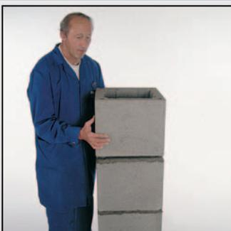
25 Установите каменную оболочку на подготовленный цементный раствор. Монтируйте дымоход индивидуально, не связывайте его с окружающей кладкой. Правило действует как для стен, так и для перегородок.
