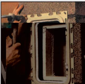
53 Дверцу снять, а раму дверцы выровнять относительно керамической рамки и прибить к блокам.
