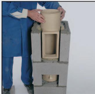
14 Установите тройник для подключения дверцы таким образом, чтобы стенки тройника располагались параллельно стенкам каменной оболочки и на одинаковом расстоянии 3 см от них. Выступ на верхней грани керамической трубы должен всегда находиться снаружи, канавка внутри. Ориентация т.н. «по воде» действует для всех видов топлива.
