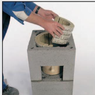
7 Следите за тем, чтобы изоляционный материал не засорял каналы вентиляции дымохода. Трубопровод для отвода конденсата выведите в отверстие вентиляционной решетки, а затем подключите к системе канализации.
