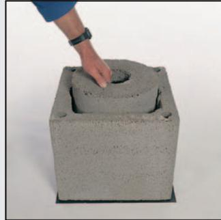
3. Установите бетонный блок-основание или залейте бетоном внутренний объём каменной оболочки. Работы с бетонной смесью вести только при температурах выше 0°C.
