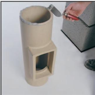
13. Перед началом монтажа всегда очищайте оба конца керамической трубы. В случае использования сухой массы для заделки швов смочите оба конца трубы влажной губкой. Нанесите шпателем массу для заделки швов на нижнюю поверхность керамического тройника для подключения дверцы.
