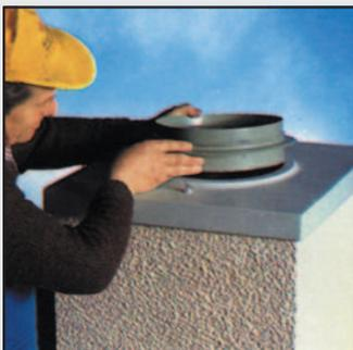
45 На покрывную плиту готового элемента верхней части дымохода установите распорное кольцо. Перед установкой нанесите на кольцо герметик.
