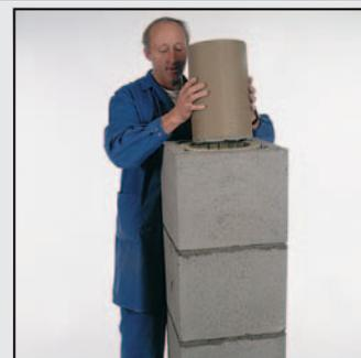
28 Установите внутрь и выровняйте керамическую трубу, удалите избыток массы для заделки швов и заглайте шов губкой. Повторите все монтажные операции в последовательности, изображенной на рис. 25-28, до устья дымовой трубы.
