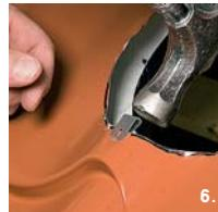
6. Насадить молотком клипсы на металличерепицу в верхней и нижней точке крепежа проходного элемента так, чтобы при крепеже шурупы прошли сквозь клипсы.
