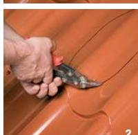
2. Вырезать отверстие в металличерепице электролобзиком строго по очерченному контуру.
