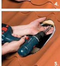
5. При битумной гидроизоляции нижнюю поверхность уплотнителя промазать резинобитумной мастикой. Прижать уплотнитель к гидроизоляции и закрепить шурупами к деревянной основе. При пленочной гидроизоляции промазать силиконом внешнюю поверхность уплотнителя (с шипами). Прижав уплотнитель к пленке снизу, наколоть пленку на шипы и уплотнить соединение силиконом. Закрепить уплотнитель шурупами к верхней и нижней рейке обрешетки.
