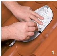
1. Очертить отверстие по шаблону. Отмеченную на шаблоне точку совместить с нижней точкой волны черепицы, в зависимости от длины профиля металличерепицы.
