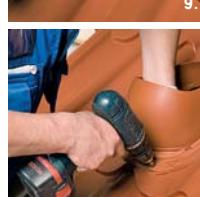
10. При сильном отклонении профиля металла от базового профиля проходного элемента возможно прокручивание боковых шурупов. В этом случае следует присверлить боковые шурупы в местах наибольшего отклонения профиля через дополнительные клипсы, что обеспечит плотное прижатие проходного элемента к металлу, затем присверлить остальные шурупы.
