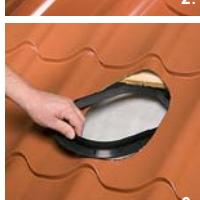
3. Вставить уплотнитель гидрозатвора в вырезанное отверстие, совместить отверстие уплотнителя с отверстием металличерепицы.
