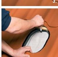
4. Обрисовать контур отверстия уплотнителя и вырезать отверстие в гидроизоляционной пленке строго по контуру.
