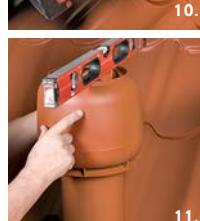
11. Установить Vilpe изделие на проходной элемент, проверив вертикальность уровнем, и закрепить шурупами.
