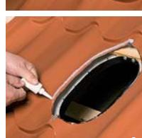
8. Смазать силиконом очерченный участок между краем отверстия и линией внешнего контура.
