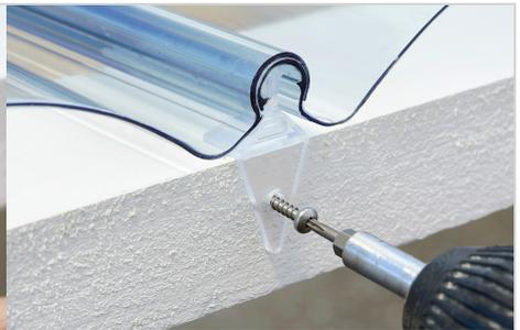
Фиксатор закрепляется к обрешетке саморезом, панель соединяется с фиксатором нажатием на буртик панели.
