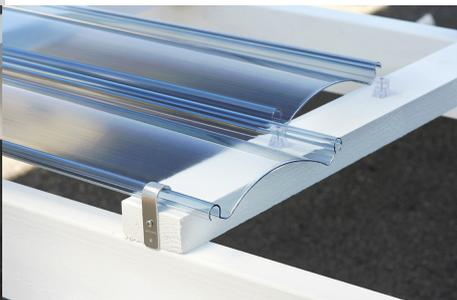
Первая и последняя панель на фронтонах закрепляется "фронтонным фиксатором" который прибивается гвоздями в торцевую часть обрешетки.
