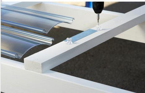
При использовании верхних фиксаторов, предварительно необходимо произвести разметку мест крепежа шаблоном имеющимся в комплекте.
